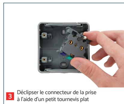
3 Déclipser le connecteur de la prise à l'aide d'un petit tournevis plat
