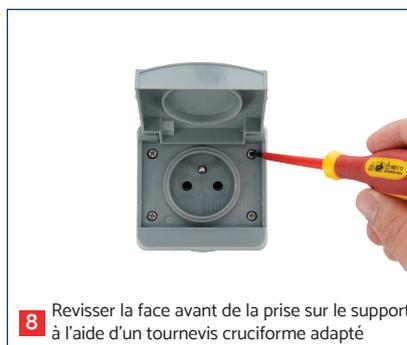
8 Revisser la face avant de la prise sur le support à l'aide d'un tournevis cruciforme adapté
