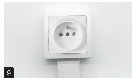
6 Effectuer le branchement puis clipser le mécanisme sur le support
