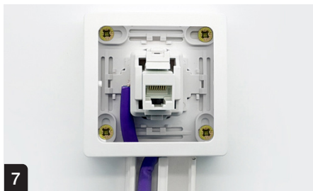
7 Clipser le cadre sur le support
