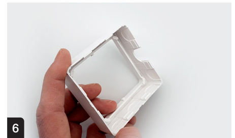
6 Découper le passage de câble sur le cadre
