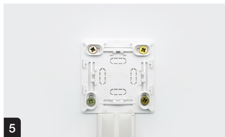
5 Fixer le support sur le mur
