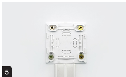
5 Fixer le support sur le mur
