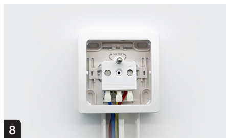
8 Clipser le cadre sur le support
