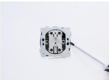
Fixer l'appareillage sur la boîte d'encastement, et contrôler l'horizontalité à l'aide d'un niveau
