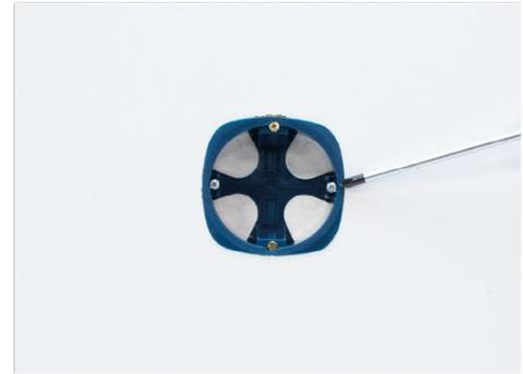
Installer une boîte d'encastement  $\varnothing 67\text{mm}$ , et contrôler l'horizontalité à l'aide d'un niveau
