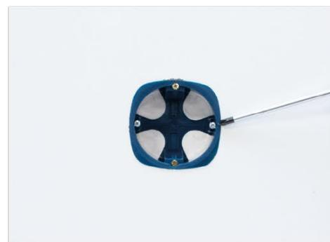
Installer une boîte d'encastement  $\varnothing 67\text{mm}$ , et contrôler l'horizontalité à l'aide d'un niveau
