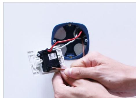
Effectuer le câblage en vous référant au schéma de câblage
