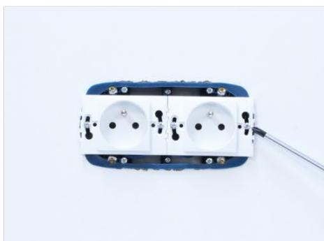
Fixer l'appareillage sur la boîte d'encastrement, et contrôler l'horizontalité à l'aide d'un niveau
