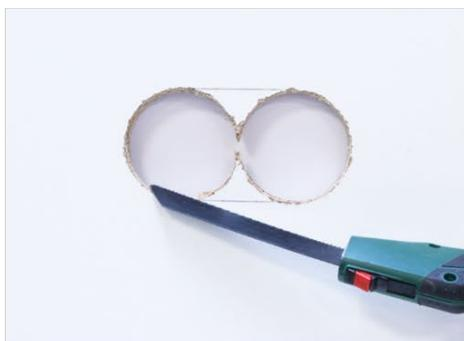
Découper la plaque de placo entre les 2 trous à l'aide d'un cutter
