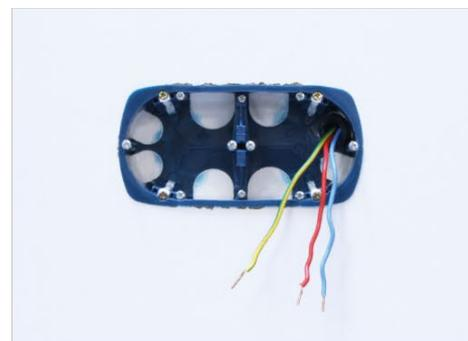
Installer une boîte d'encastement double, et contrôler l'horizontalité à l'aide d'un niveau
