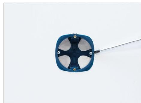
Installer une boîte d'encastement Ø67mm, et contrôler l'horizontalité à l'aide d'un niveau
