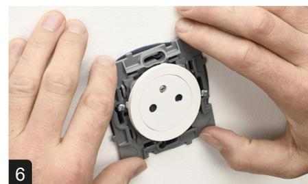
**6** Poser le mécanisme en l'inclinant vers la gauche
