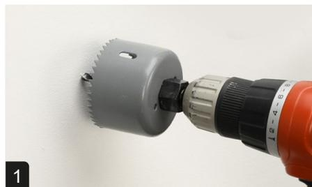
**1** Percer le trou de boîte Diamètre 67mm
