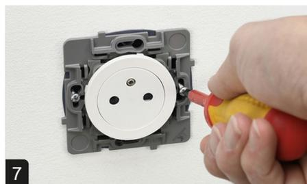
**7** Ajuster et visser le mécanisme horizontalement
