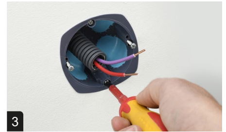
2 Installer la boîte d'appareillage ( griffes verticales )
