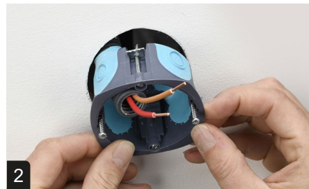
3 Fixer la boîte en serrant les vis verticales
