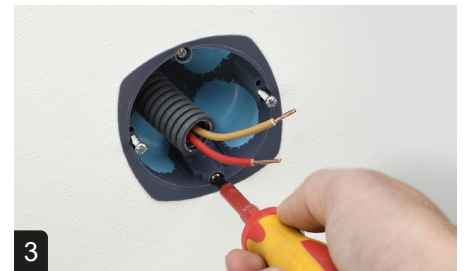
2 Installer la boîte d'appareillage ( griffes verticales )
