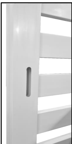
Face avant du portail, vue extérieure
