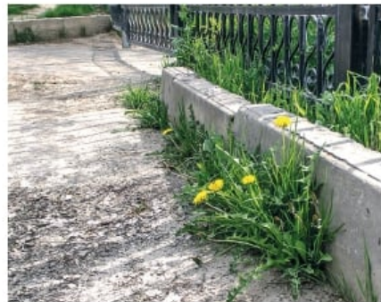
Bordures et trottoirs
